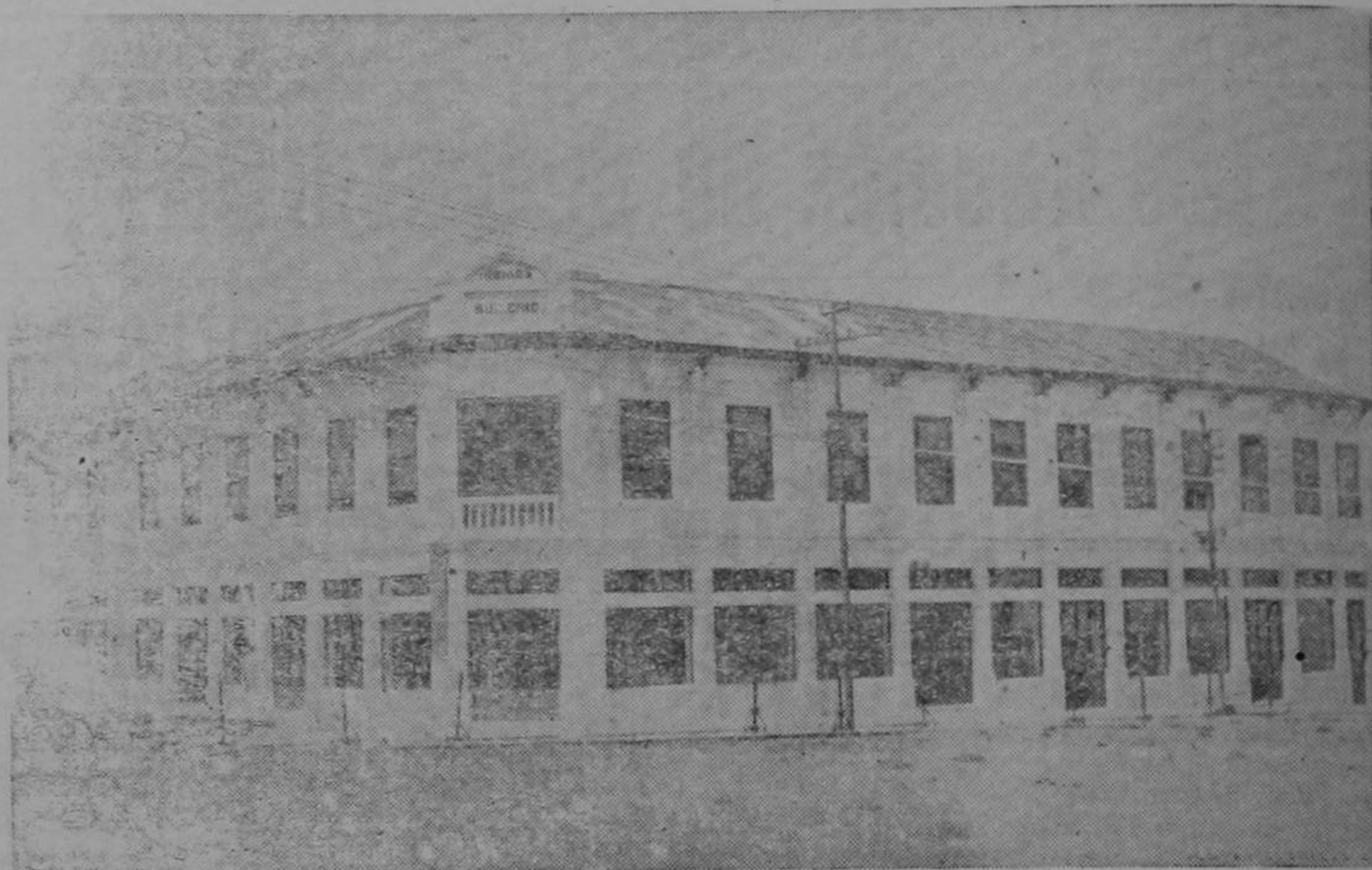
El edificio MIRHIGE BROTHERS, en cuyo interior están instaladas las GRANDES TIENDAS DE 5 & 10 Cts. está instalado en punto céntrico y apropiado para el cliente. Sus tiendas han abierto al público una VERDADERA REALIZACION de mercaderías a precios como ninguna otra tienda los puede tener. Hay de todo lo que pueda desear el parroquiano y para el gusto más exigente. Visítela hoy mismo para que continúe siendo nuestro cliente.
